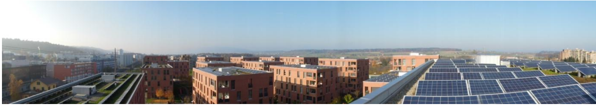
Die Anlage Ruggächern, auf viele Dächer verteilt
